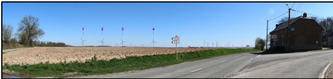
Figure 10 : Sur la D12, en sortie Sud de VILLERS-LE-SEC, angle de 120°
